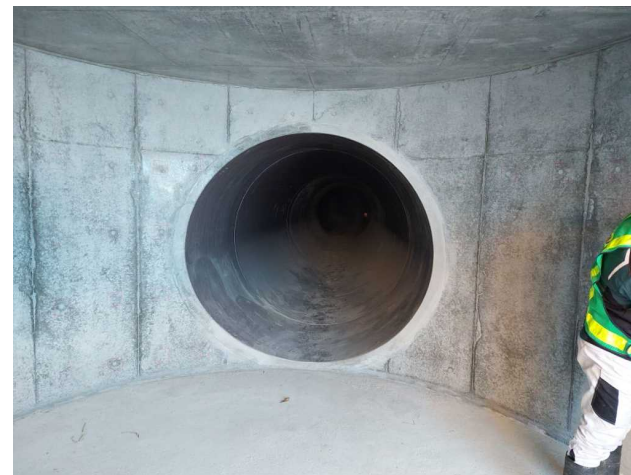
出庭4工区 施工状況
