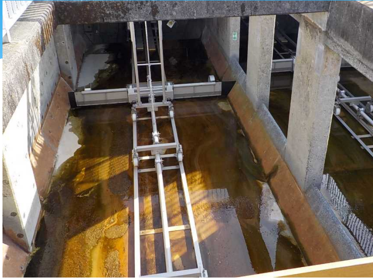
最初沈殿池 掻き寄せ機 更新
