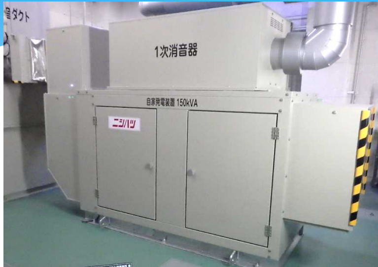
自家発電装置 更新
