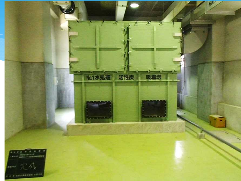
水処理脱臭機械 更新
