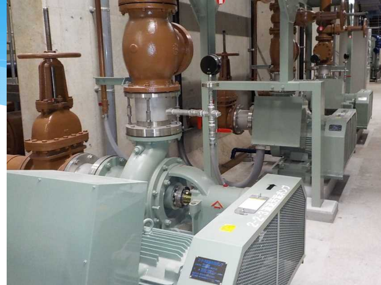
最終沈殿池 返送汚泥ポンプ 更新
