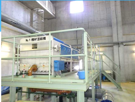
汚泥濃縮機 更新
