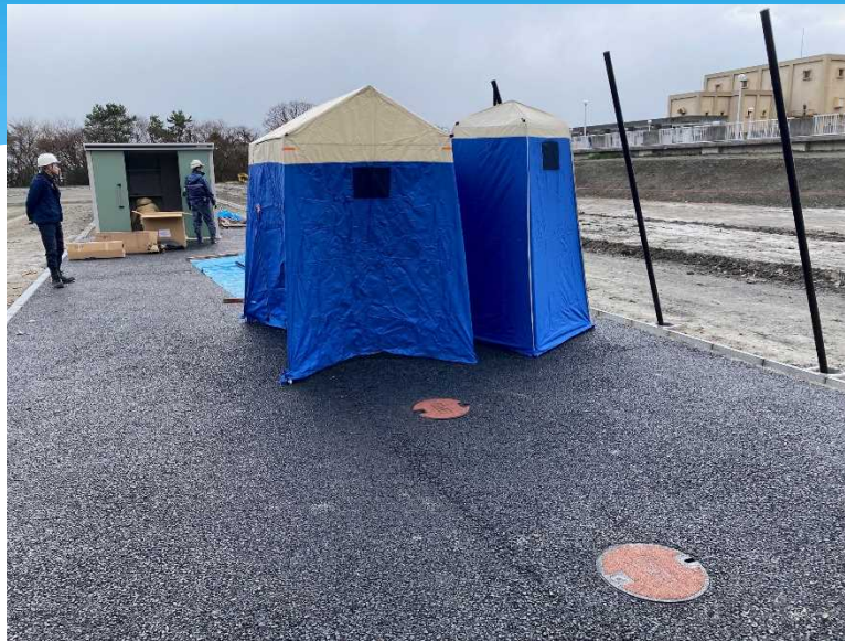
湖西浄化センター マンホールトイレ
