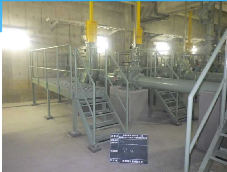
主ポンプ 更新
