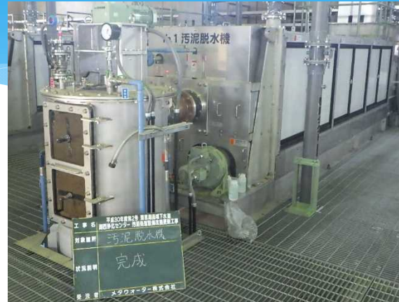
汚泥脱水機 更新
