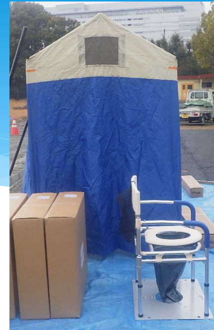
マンホールトイレ 上屋
