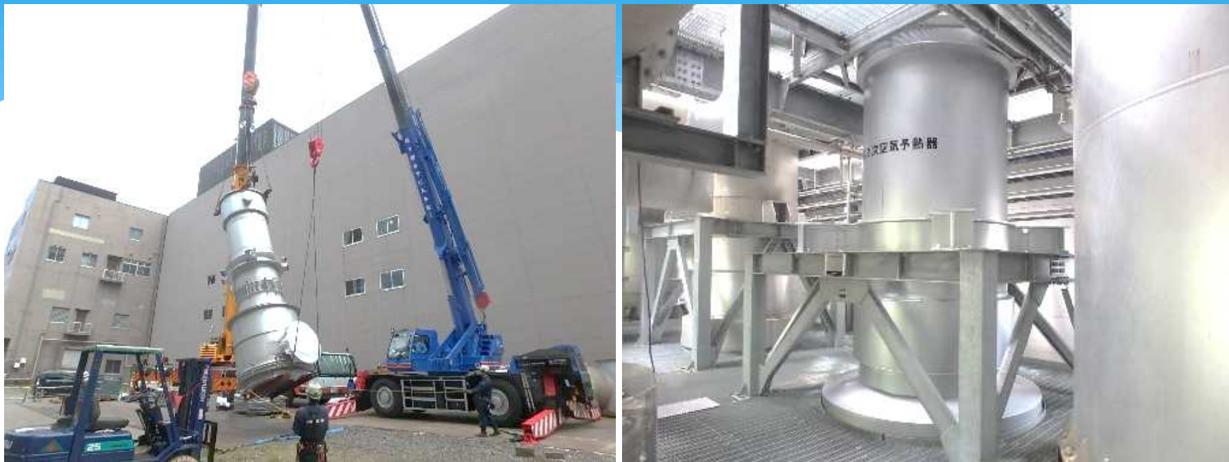
汚泥焼却設備 更新（空気予熱器等）
