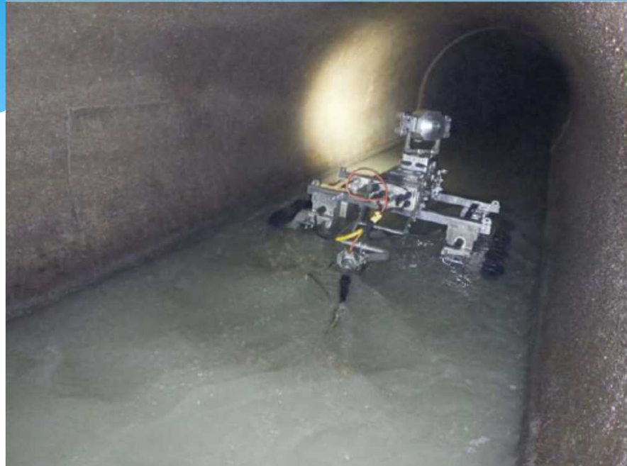
テレビカメラ自走車 管内調査状況
