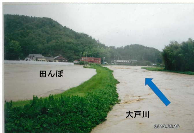
図 3 平成 25 年台風 18 号による被害状況
