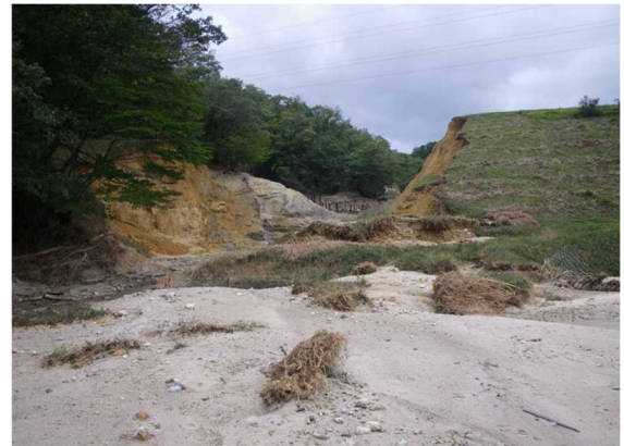
図Ⅲ-2 H29 台風 21 号によるため池堤体の決壊
