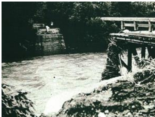
杣川・金太橋流出 (昭和28年9月25日洪水)
