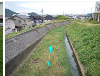
② 新上鈎橋下流
