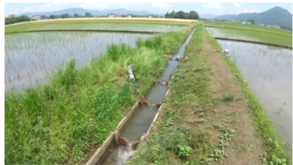
図1 堰上げした水田水路
