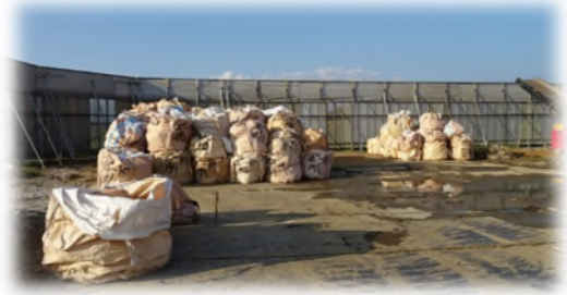
フレコンバッグによる保管
