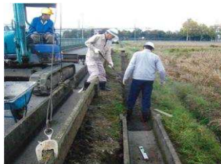
用水路の補修・更新
