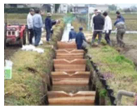
水路魚道の設置（堰上げ式）
