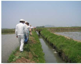
排水（漏水）調査
