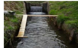
水路からの脱出施設設置
