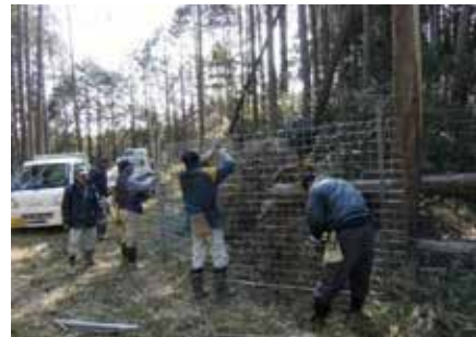
獣害防止柵の補修
