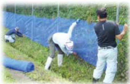
防風ネットの設置作業(甲賀市水口町)
