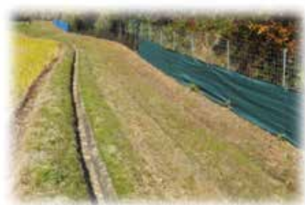
防草シートの設置事例(水口町)
