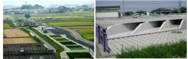
山寺川市街地排水浄化施設「伯母川ピオ・パーク」
