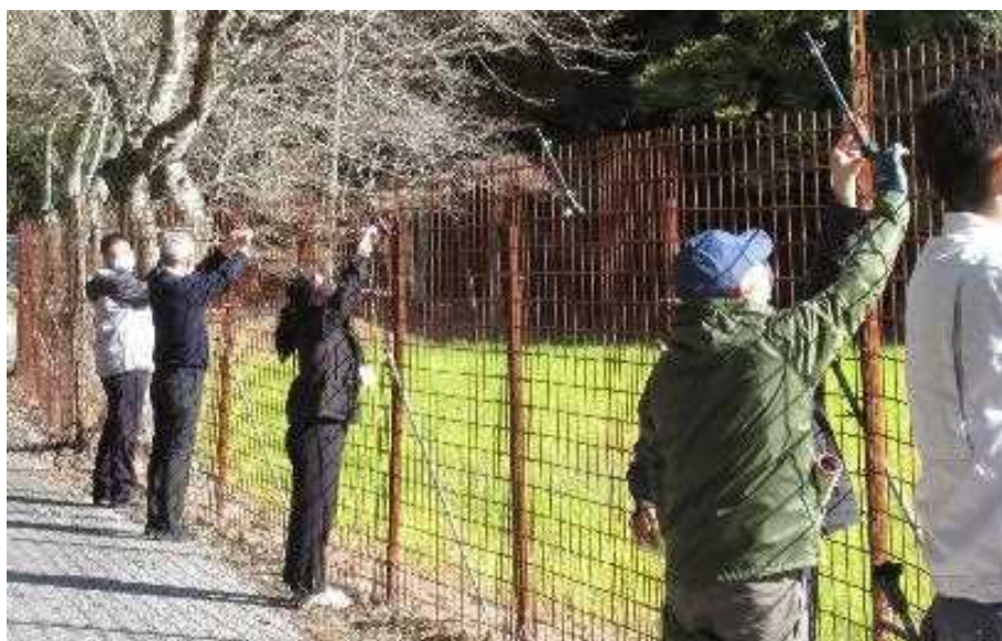
WM柵への設置作業の様子
