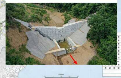
写真④ アコ谷: 堰堤工(R3.6月状況)
