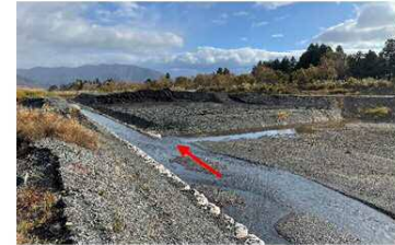
写真③ 一の瀬川: 溪流保全工(R4.2月状況)
