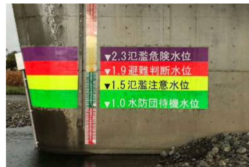
近景(右岸側側面・CCTV側)
