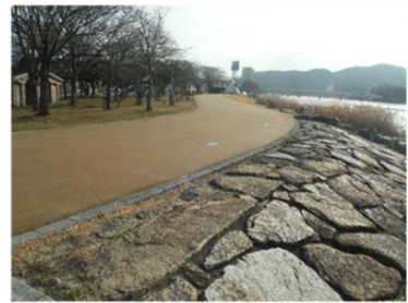
公園内通路の整備
