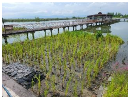
木浜内湖底質改善対策（覆土工） （守山市木浜町他）
