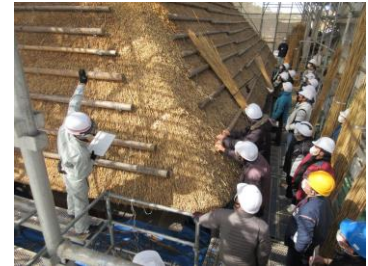
国指定重要文化財 西徳寺本堂 保存修理工事現場公開
