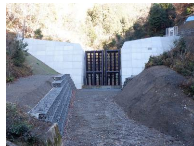
坪谷川砂防堰堤（長浜市）
