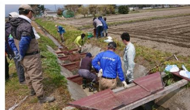
写真 野洲市須原での魚道設置のようす
