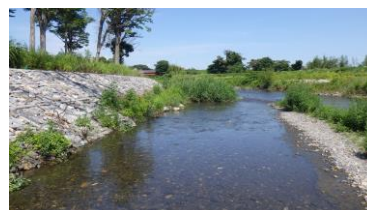
石田川多自然川づくり (環境保全カゴ型護岸) (高島市今津町福岡他)
