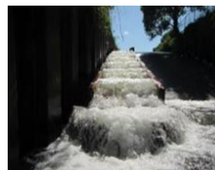
落差工に設置した魚道
