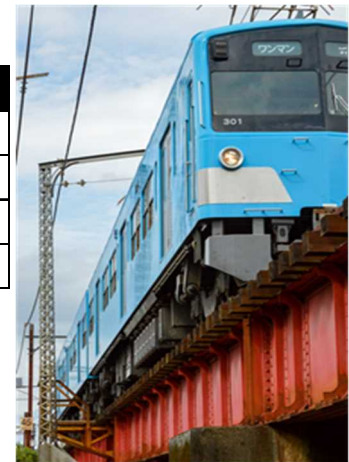
築造後100年以上経過する橋梁
