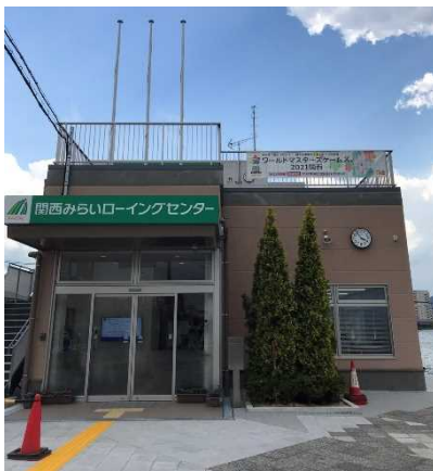
管理棟・艇庫入り口を撮影
