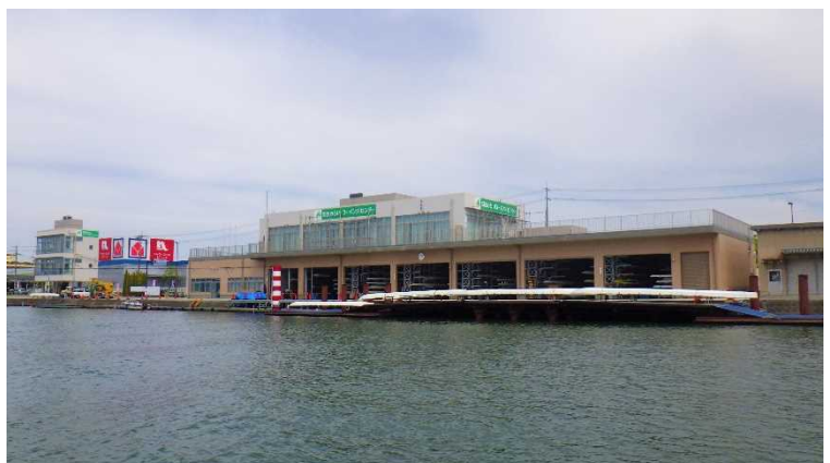
管理棟・艇庫を琵琶湖から撮影
