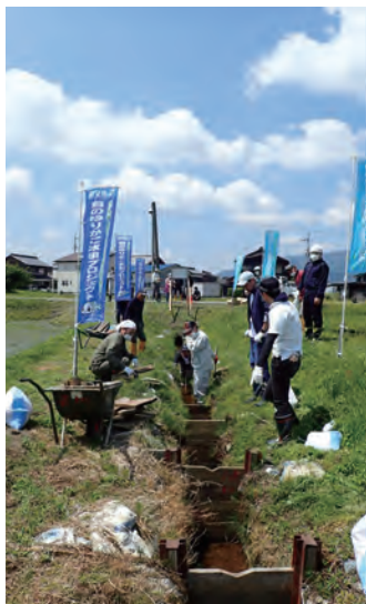
魚のゆりかご水田の堰板設置の様子
