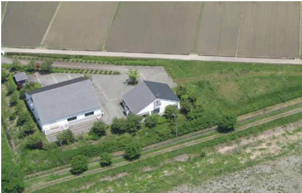
▲高島市朽木浄化センター
