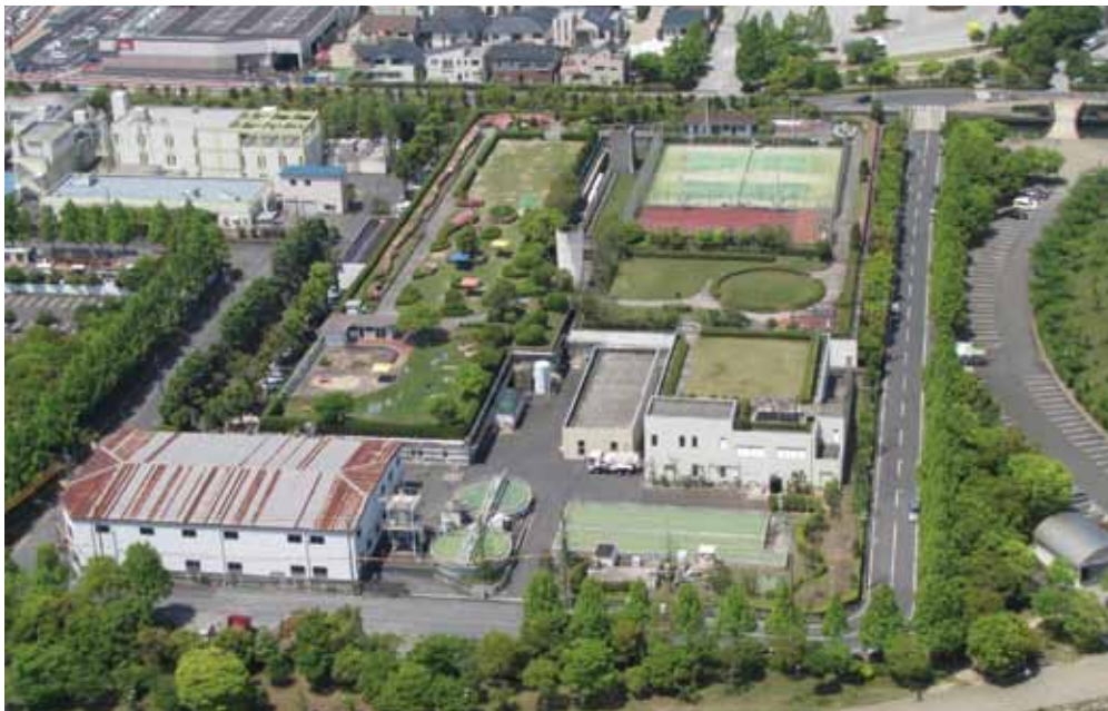
▲大津市水再生センター
