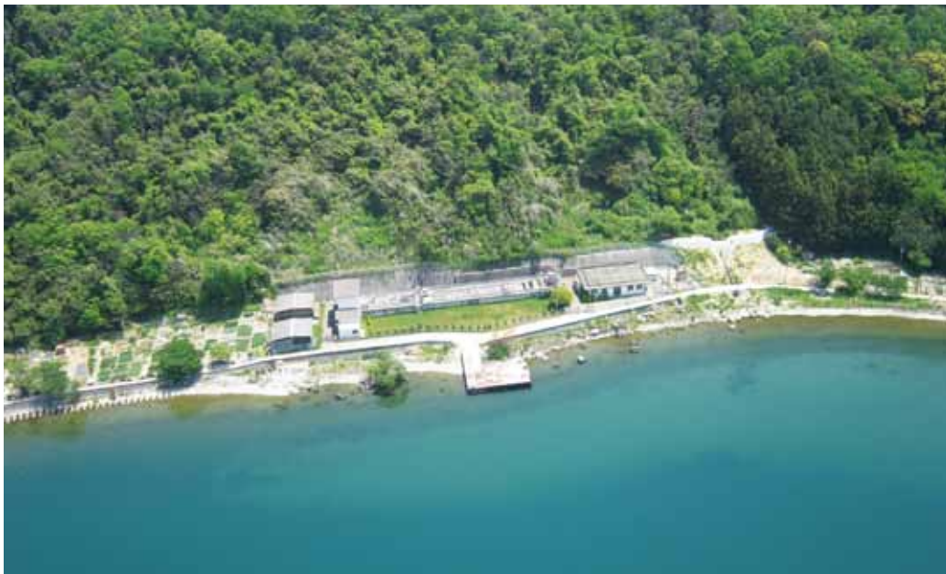
▲近江八幡市沖島浄化センター
