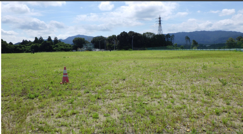
写真② 天端部の様子
