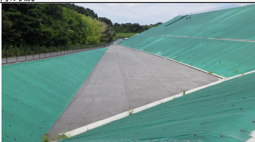
写真① 西市道側の様子
