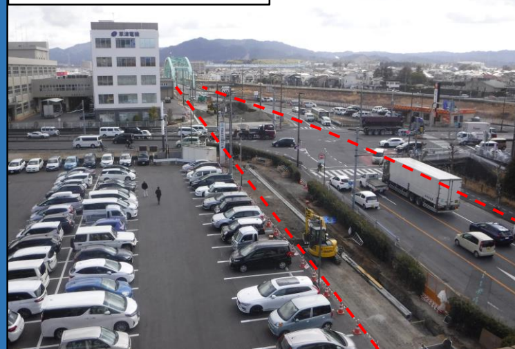
工事中(2022年2月撮影)
