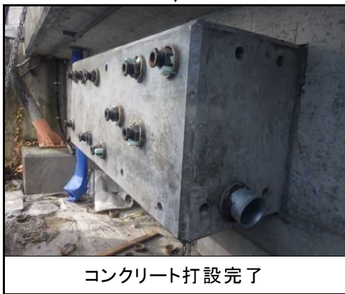
写真-3.2.6 外ケーブル工の流れ(2)
