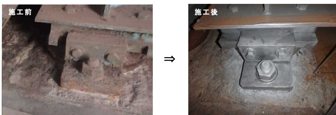
写真-3.4.1 金属溶射工の施工例
