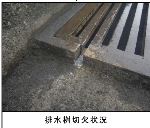
写真-3.4.5 橋面防水工の流れ(2)
