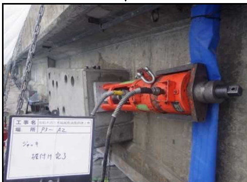
補強ケーブルの緊張
