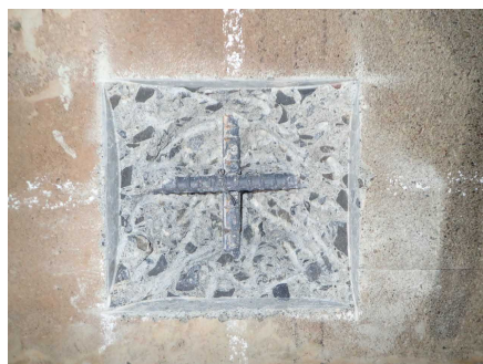
写真-2.4.5 はつり調査の例
