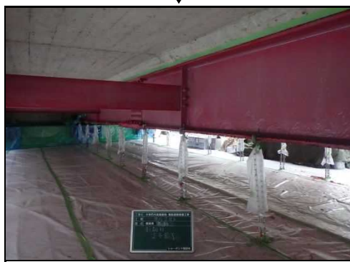
剥離材塗布完了
