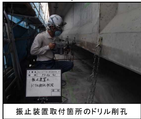
写真-3.2.6 外ケーブル工の流れ(2)
