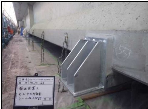
振止装置取付完了
