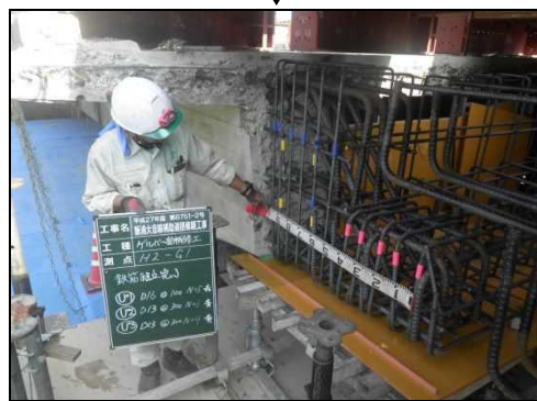
鉄筋組立完了
