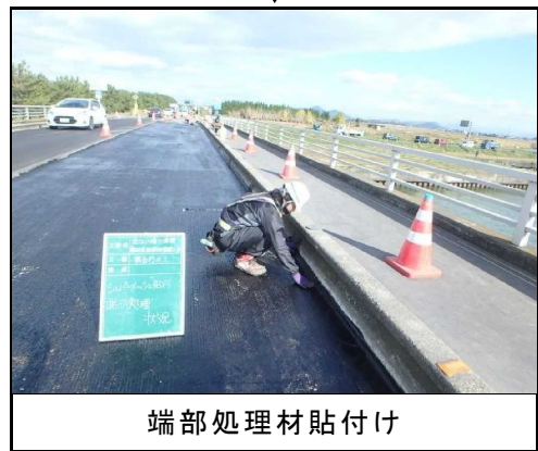
床版防水材のプライマー塗布
