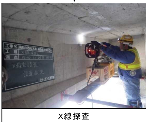
写真-3.2.5 外ケーブル工の流れ(1)
