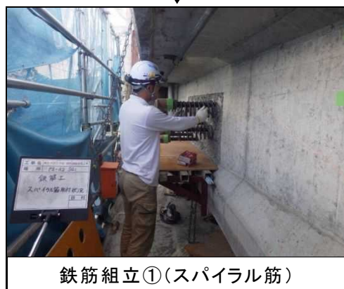
写真-3.2.5 外ケーブル工の流れ(1)
