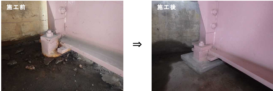
写真-3.4.2 塗装塗替え工の施工例
