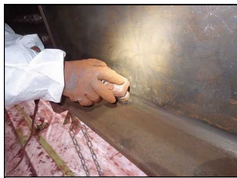
動力工具処理
