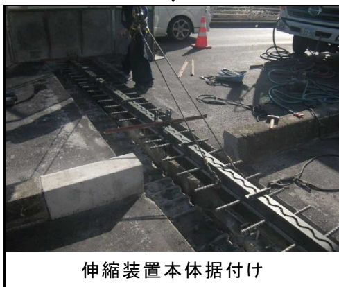
写真-3.4.3 伸縮装置取替え工の流れ
