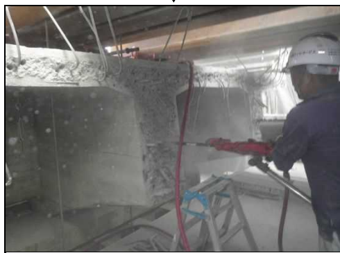
鉄筋設置孔の削孔
