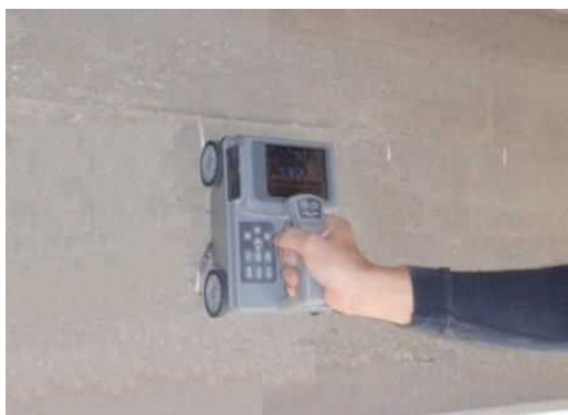
写真-2.4.4 鉄筋探査の例
