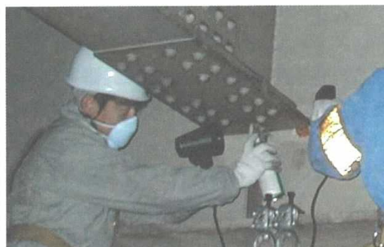
写真-2.4.8 磁粉探傷試験状況 1)
