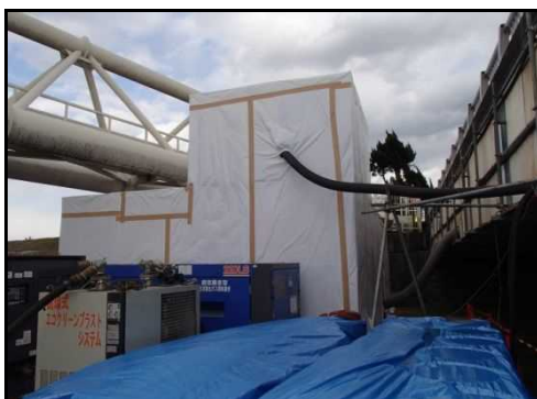
ブラスト機械設備養生
