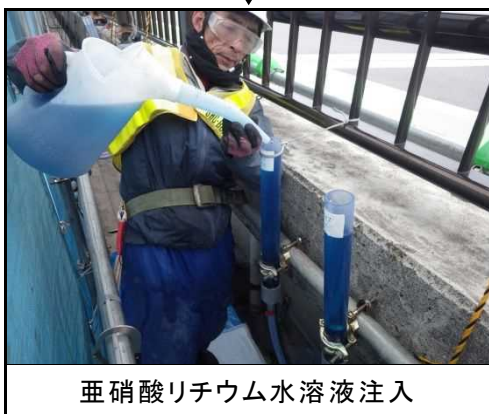
写真-3.2.4 グラウト再注入の流れ
