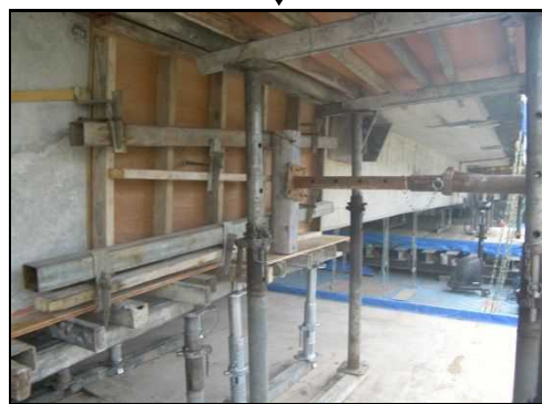
型枠設置～コンクリート打設
