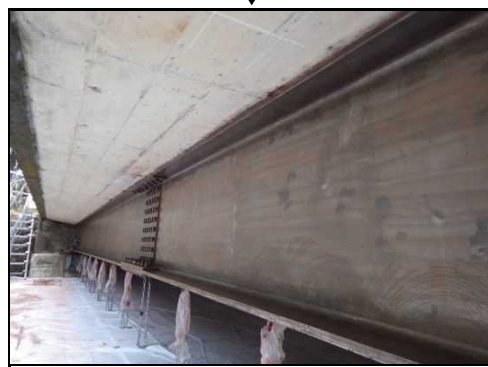
素地調整完了
