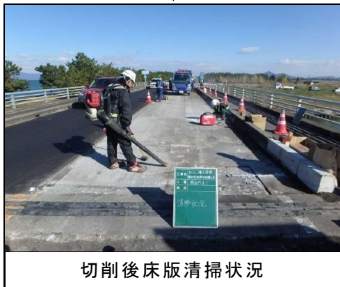
写真-3.4.4 橋面防水工の流れ(1)
