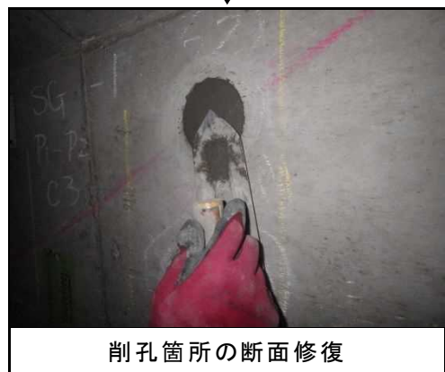
写真-3.2.4 グラウト再注入の流れ
