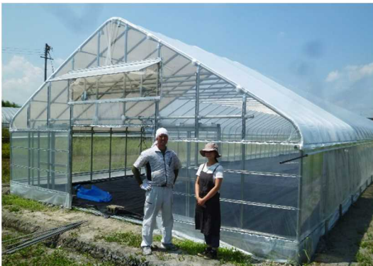
自家施工されたパイプハウス
