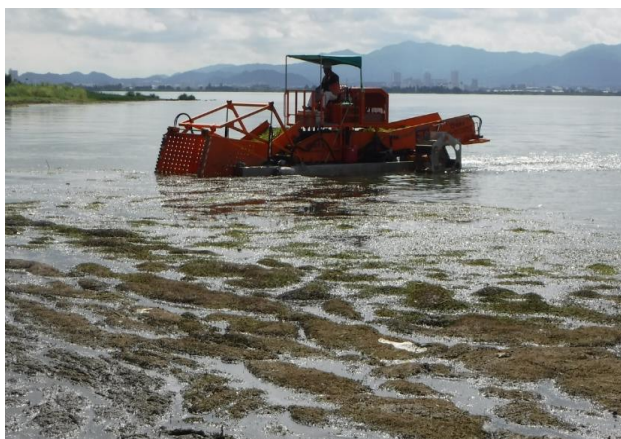
[大量繁茂した水草の除去作業]
