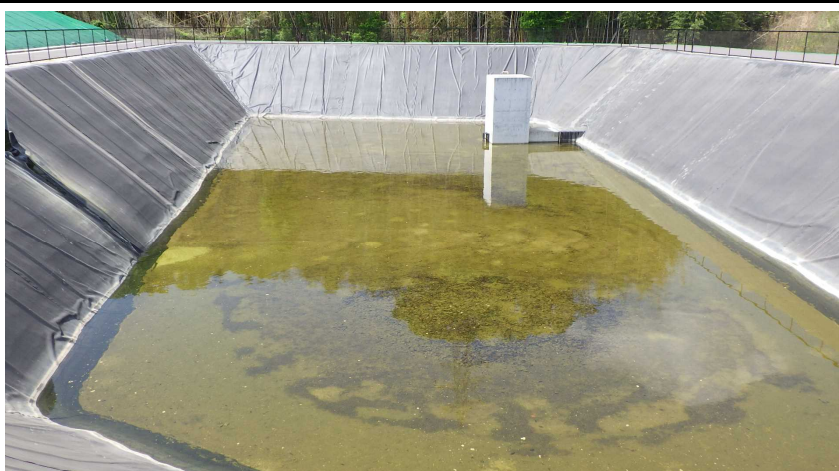
写真① 調整池付近の様子
