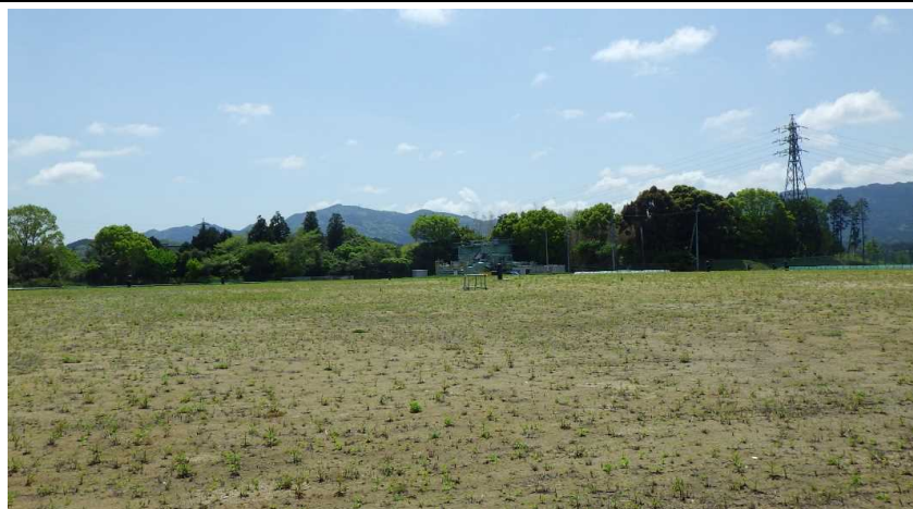
写真② 天端部の様子
