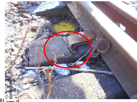
④金具の状況
