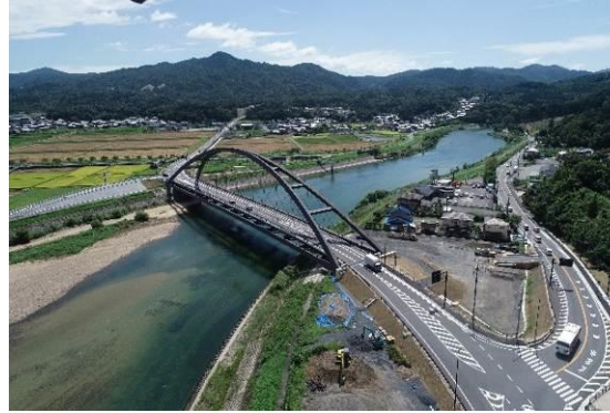
図 国道422号 大石東バイパス 瀬田川令和大橋(大津市)
