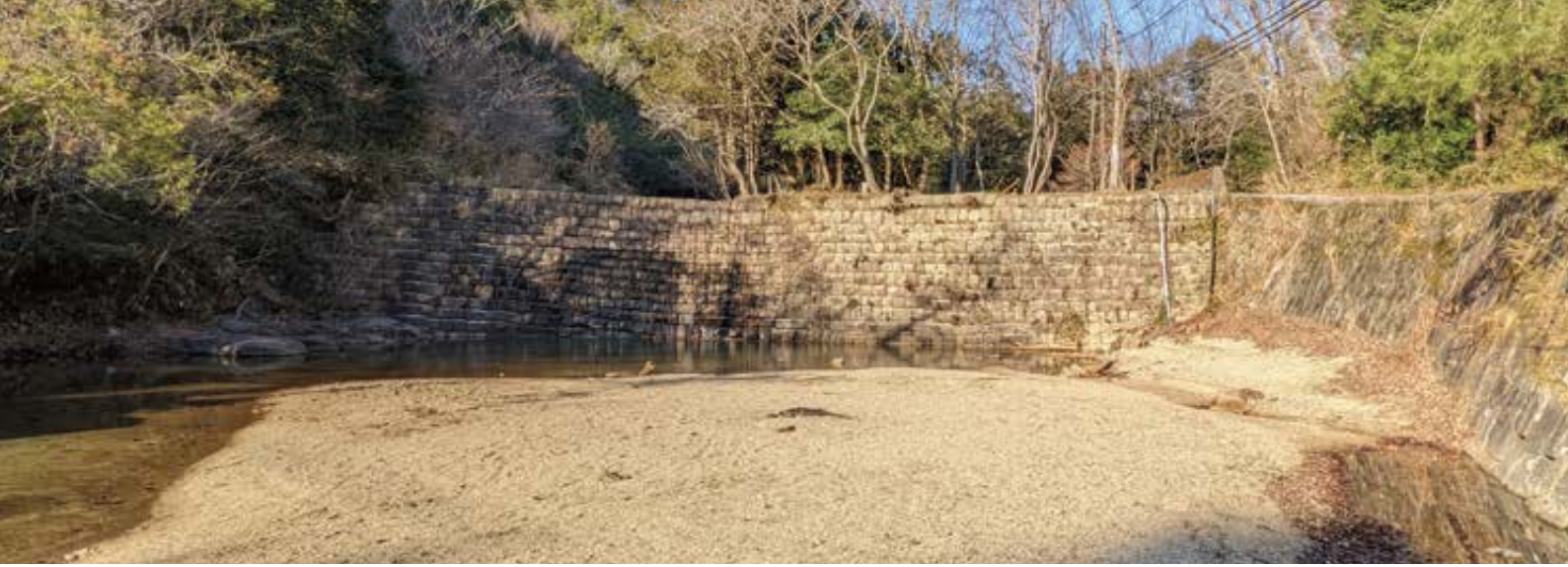
▲図18：オランダ堰堤（大津市上田上桐生町）
