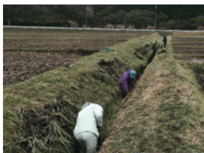
共同活動(排水路の泥上げ)
