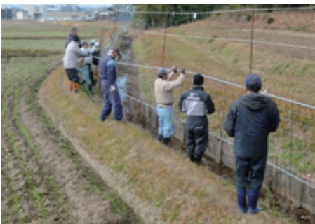
獣被害緊急対策作業 (ワイヤーメッシュを2段に)
