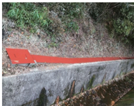
水路に蓋を掛け掃除の省力化
