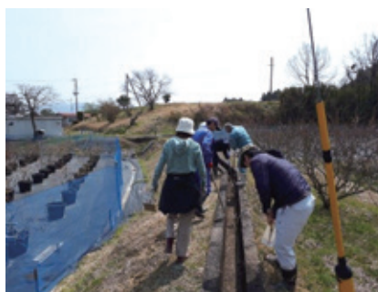
共同作業（用水路の泥上げ）
