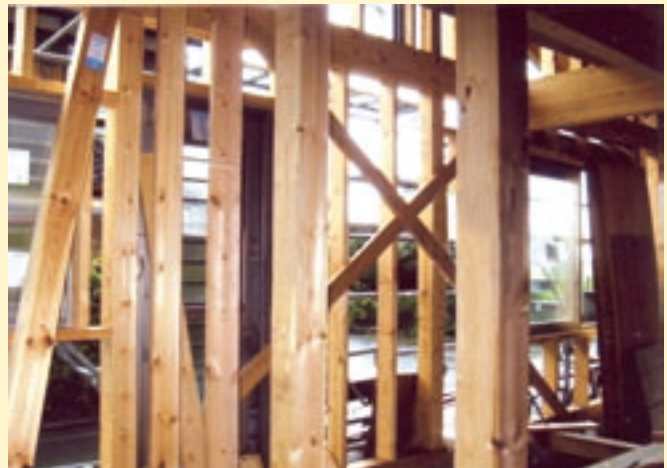
構造用合板 施工前の状況
