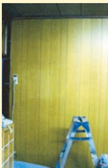
補強前の状況
