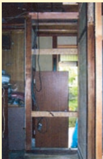
壁仕上げ材撤去
