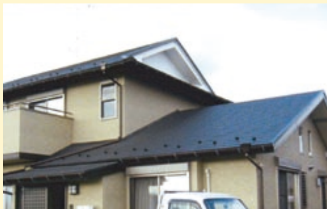
改修後：平屋根スレート
