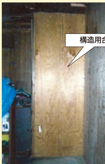
構造用合板による補強
