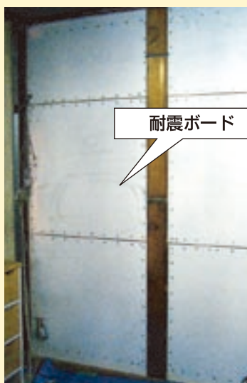
耐震ボードによる補強
