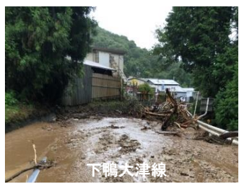
図 2021年8月の台風18号による道路被害状況
