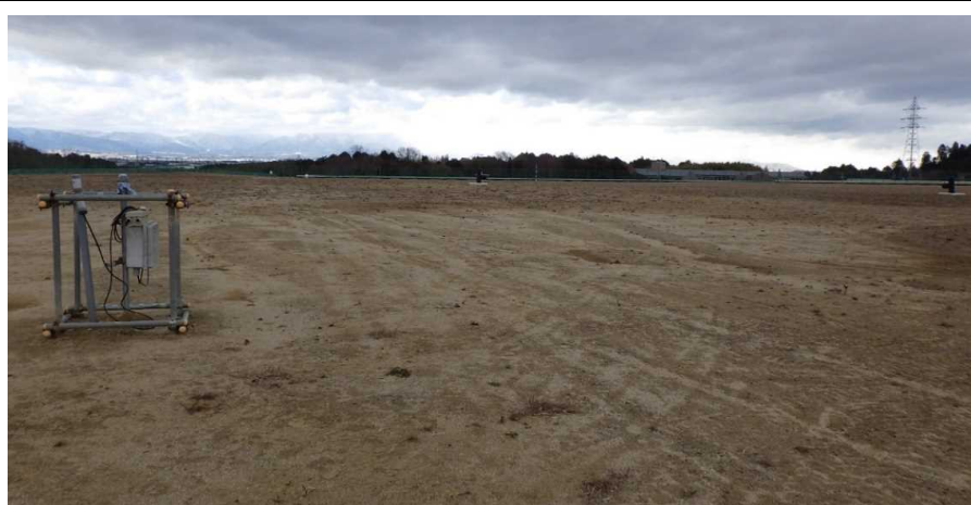
写真② 天端部の様子
