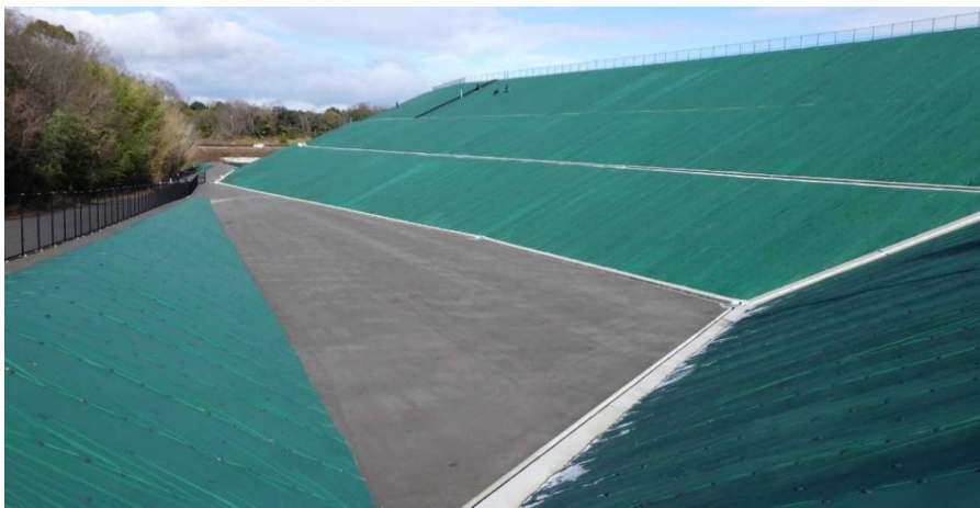
写真① 西市道側の様子
