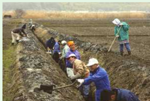
水路の泥上げ
