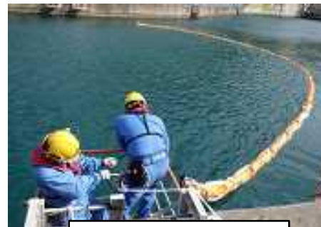
シルトフェンス設置
