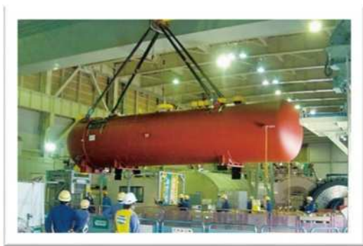
高圧給水加熱器の取替え
