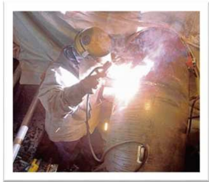
配管の取替え
