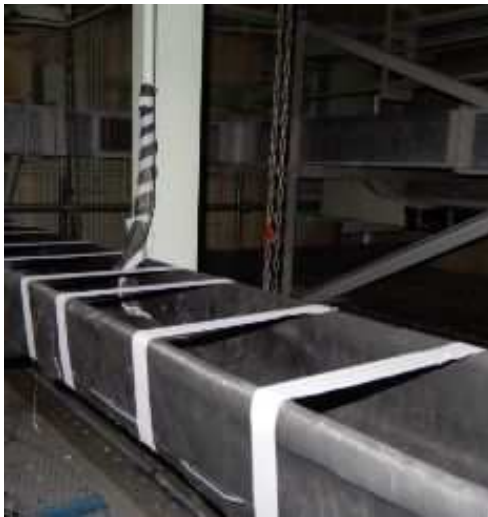
<防火シート施工箇所>
