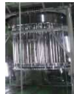
上部炉心構造物
