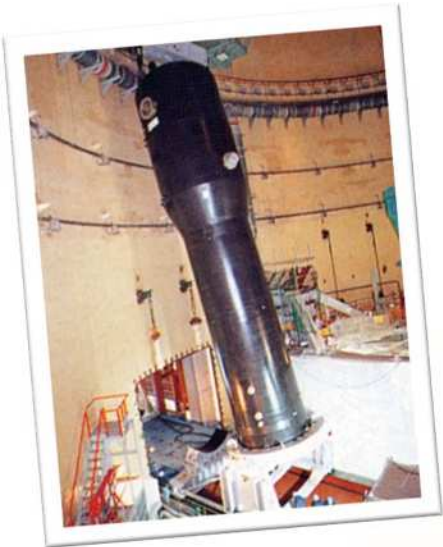
蒸気発生器の取替え
