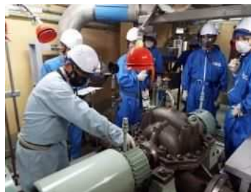
【回転機器の振動確認の状況】
