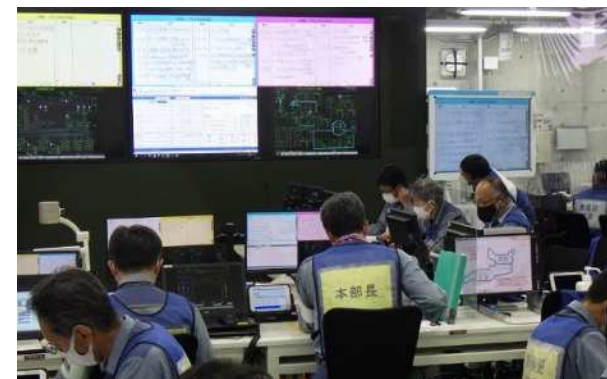
高浜発電所（9/24） 緊急時対策所
