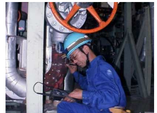
配管の厚み点検
