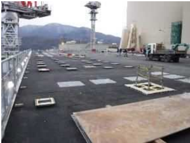
新構台の上部（現状）
