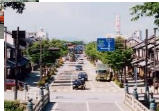
滋賀県における潤いある空間としての道路整備事例
