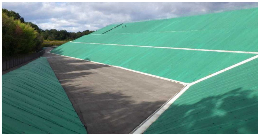
写真① 西市道側の様子
