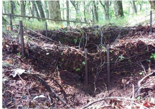
図 4.1.2 金網柵工の施工例
