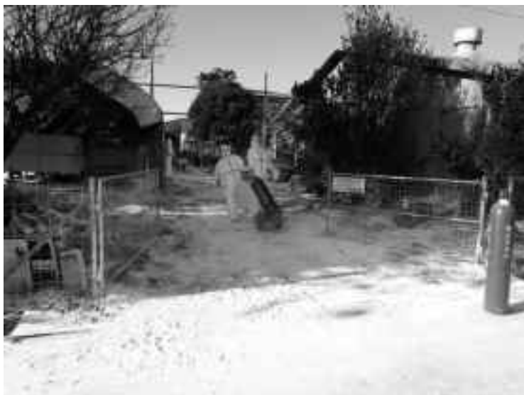
ガスポンベの供給
