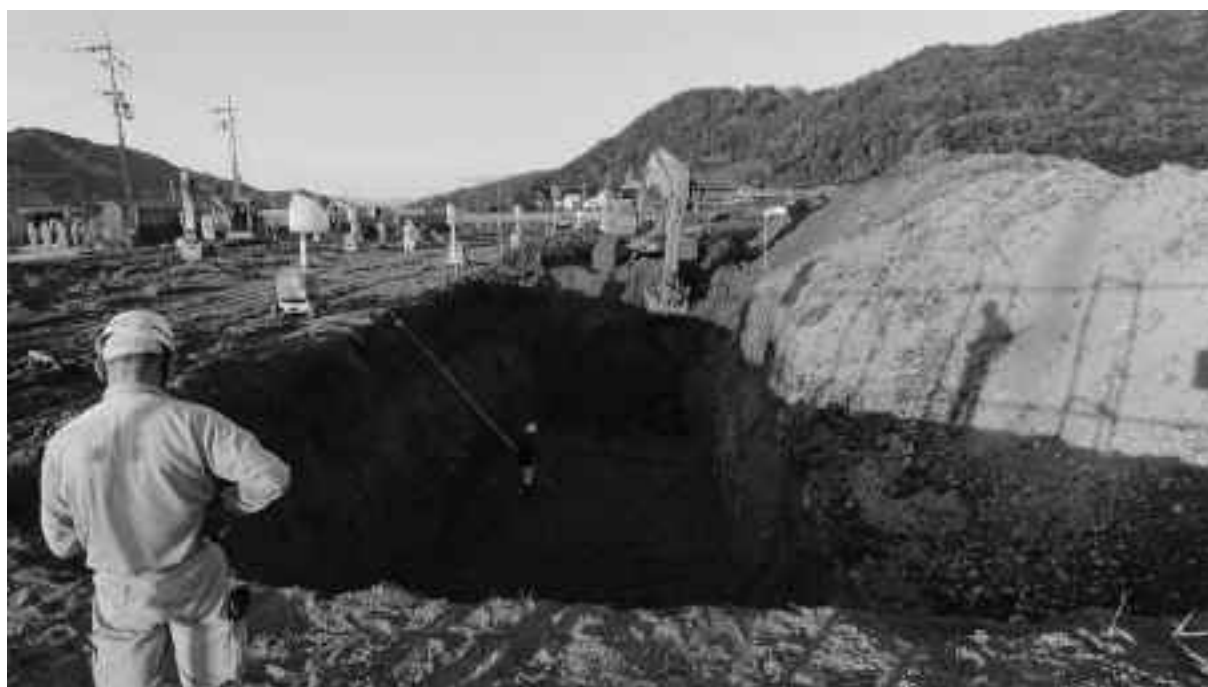
埋却地の掘削
