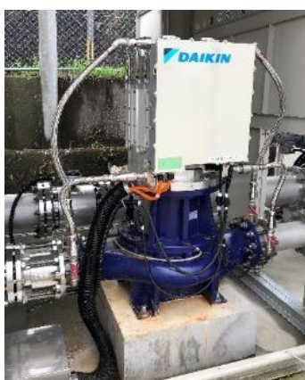
管路用マイクロ水力発電システム (近江八幡市長福寺町)
