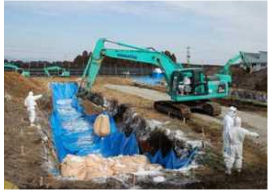
埋却地での作業
