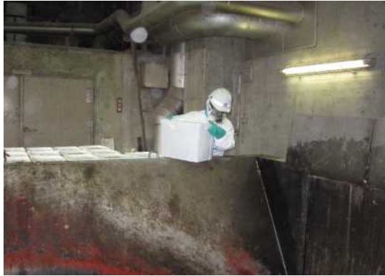
焼却施設での作業
