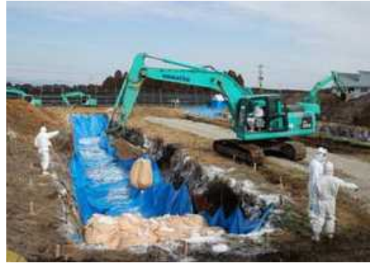
埋却地での作業
