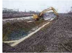
河道掘削 (石狩川水系、北海道開発局)
