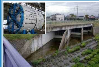
雨水幹線整備
