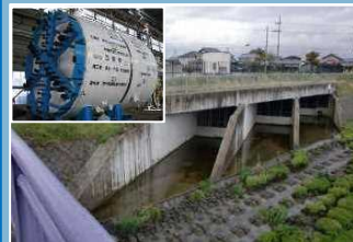
雨水幹線整備
