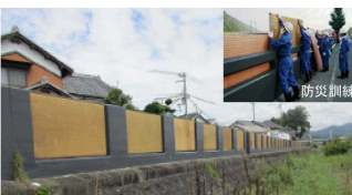
自主防災活動による畳堤設置 (揖保川水系、たつの市)
