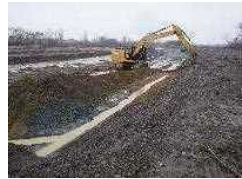
河道掘削 (石狩川水系、北海道開発局)
