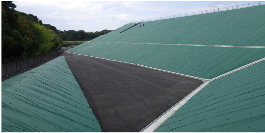
写真① 西市道側の様子
