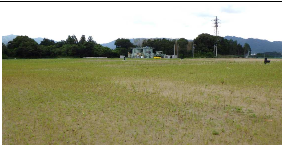
写真② 天端部の様子
