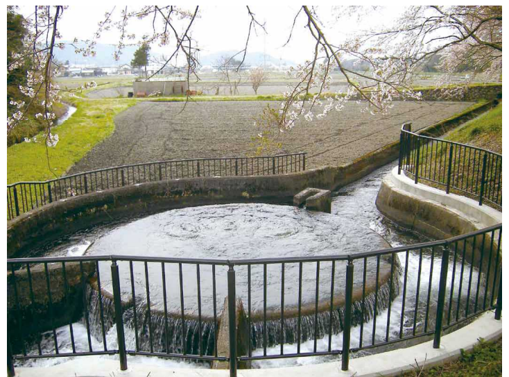
▲サイホンの原理を利用した円形分水（米原市）
